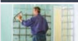
8. Wenn die Wand komplett fertig gestellt und der Kleber 24 Stunden getrocknet ist, verfüllen Sie die Fugen mit flexiblem Fugenmörtel passend zur Farbe Ihrer Glasbausteine. Wand- und Bodenfuge müssen beidseitig dauerhaft elastisch ausgeführt werden!
