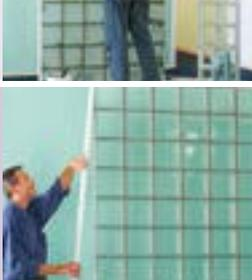
9. Dieser Schritt beendet den Bau der Wand. Sie können nun die noch sichtbaren Seiten der Glasbausteine mit farblich passenden Abschlussleisten aus Holz, Kunststoff oder Metall verkleiden.
