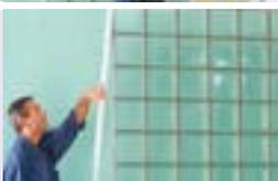
6. Dieser Schritt beendet den Bau der Wand. Sie können nun die noch sichtbaren Seiten der Glasbausteine mit farblich passenden Abschlussplättchen bzw. Abschlussleisten aus Holz, Kunststoff oder Metall verkleiden.
