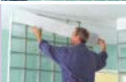
7. Verblendung zur Decke und Abdeckung der Seiten mit Profilen aus Holz, Kunststoff oder Metall.
