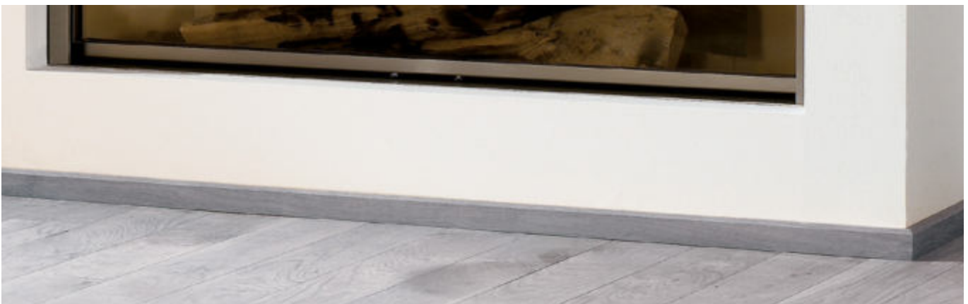
Fußleiste Eiche massiv, 20 x 55 mm, gefast, bauseits behandelt mit 3074 Graphit (Hartwachs-Öl Farbig)
