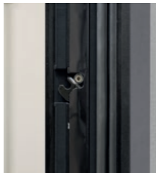
Der Verschluss mit pferdekopfförmiger Verriegelung im Rahmen
