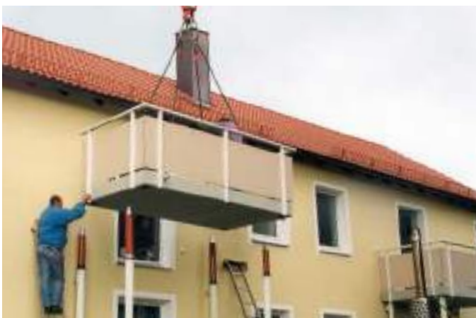
4. Balkon wird aufgefädelt
