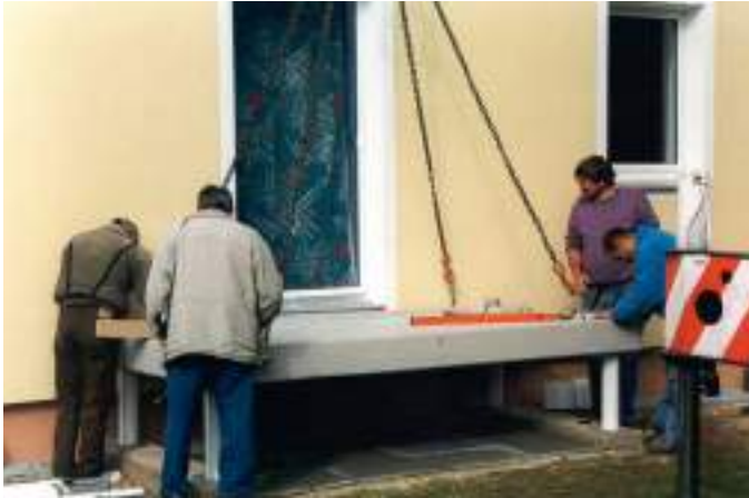
1. Bodenplatte EG wird versetzt
